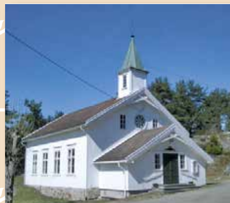
Justøy kapell Brekkestøveien, 4780 Brekkestø
